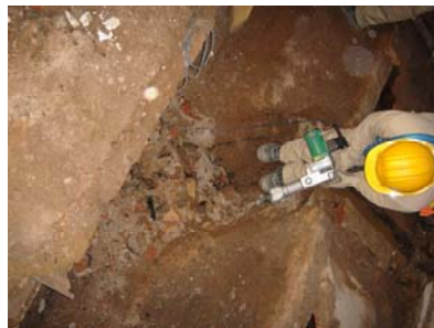
005 UE 101 desmuntatge .JPG
