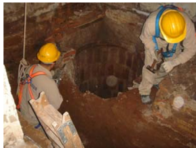
018 UE 104 desmuntatge .JPG
