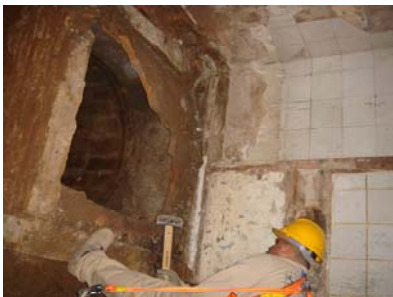
017 UE 104 desmuntatge volta .JPG
