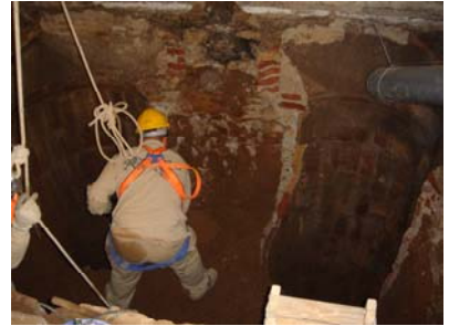
028 UE 106 excavació .JPG
