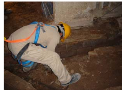
022 UE 105 desmuntatge .JPG
