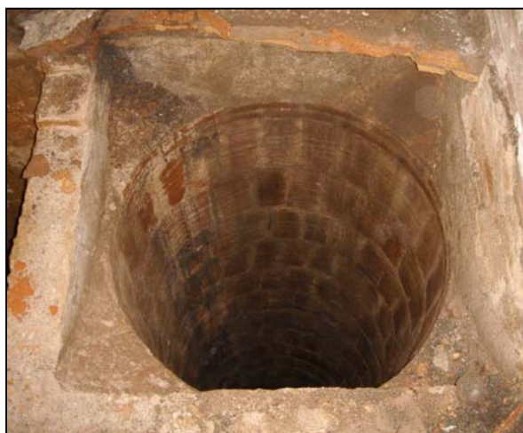
Detall de les característiques constructives del pou UE 104. A dalt, part superior del pou, i a baix, detall de la planta circular. Cal mencionar que tota l'estructura està realitzada amb maó massís i morter de calç
