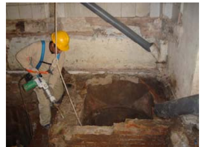
009 UE 102 desmuntatge .JPG
